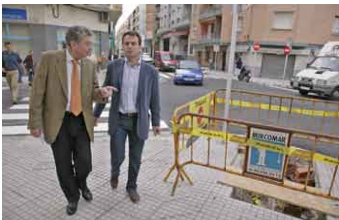
Foto: Fernando Mut y Vicent Mengual visitando las obras.
